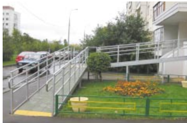
Пандус, запасной выход из подъезда дома 7 корпус 1 по ул.Салтыковской.
